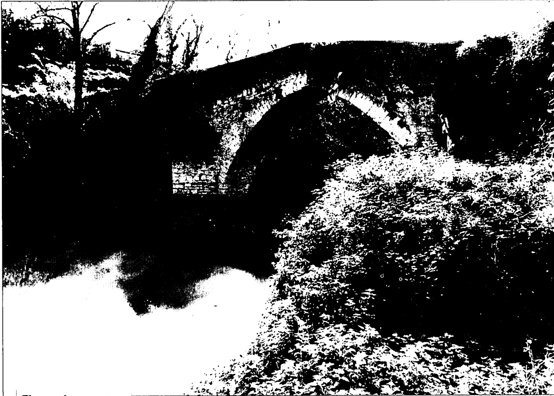
Figura 4. Puente medieval de Brañes. (Oviedo -Asturias).
