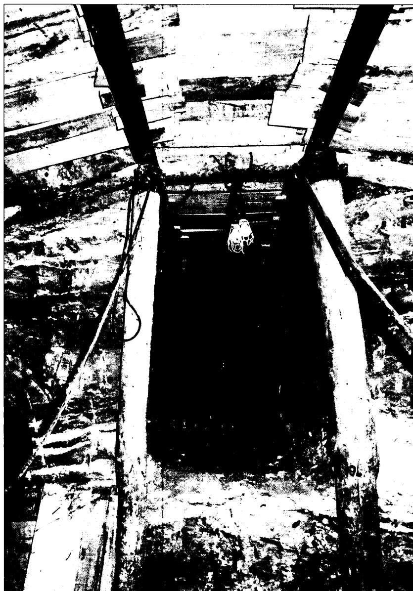
Detalle de una excavación por el Método Belga.
