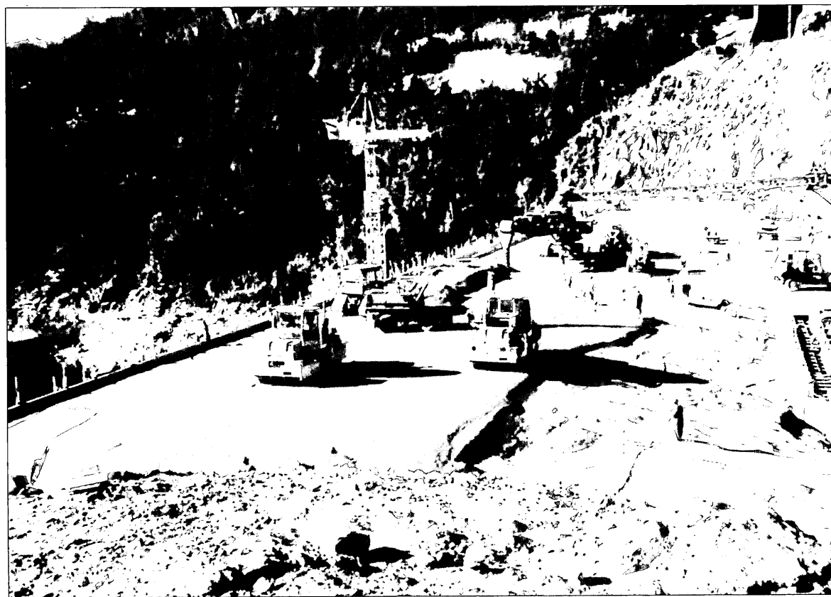
Compactación del hormigón.
