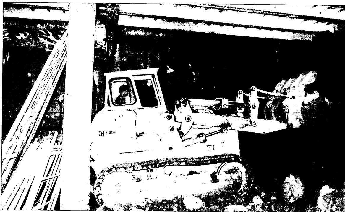
Excavación bajo el forjado.
