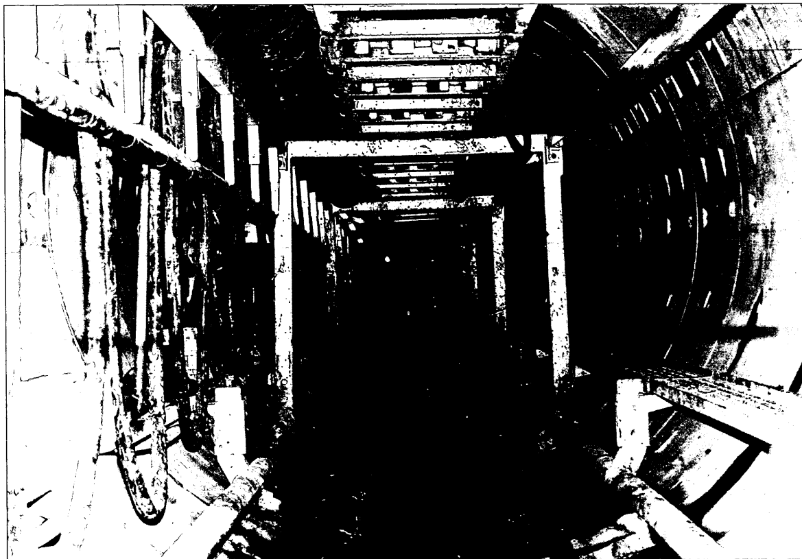
Vista del frente del túnel (Back-up).
