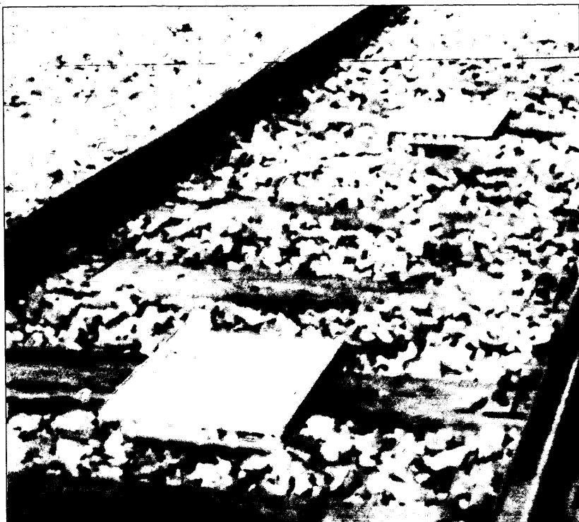
Figura 8. Balizas pasivas en vía. (Cortesía de "AB B Signal").
