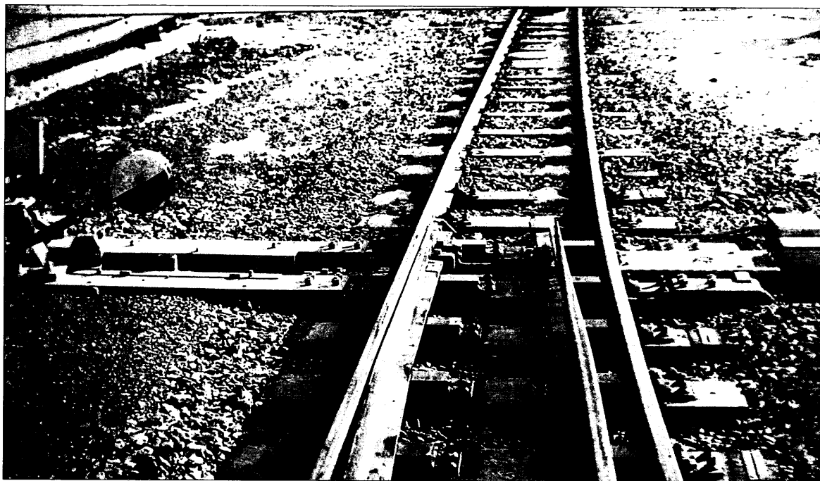
Figura 3. Desvío talonable. (Cortesía de "Voest Alpine Eisenbahnsysteme").
