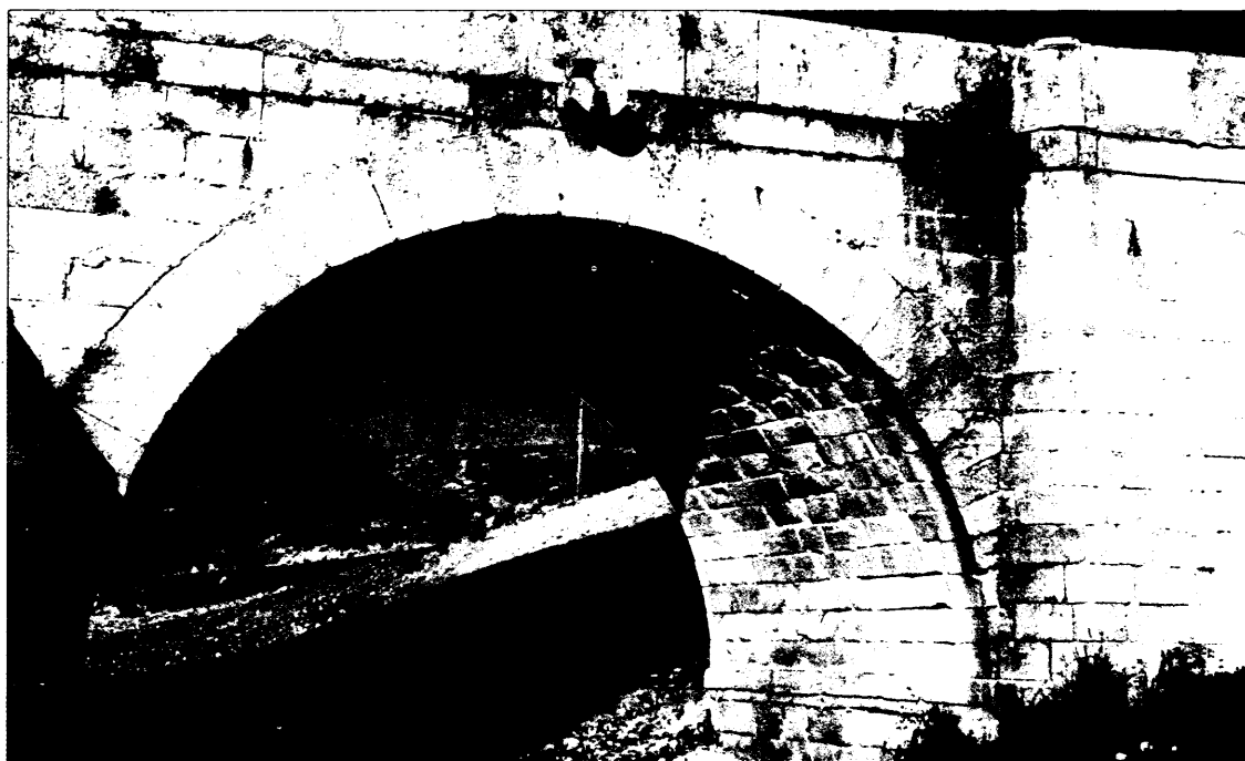
Puente del Retamar. Bóveda.
