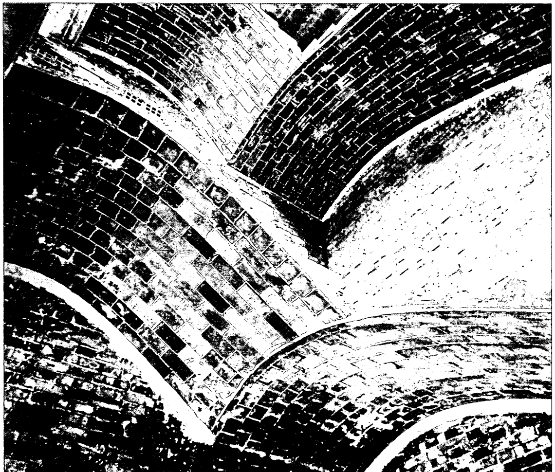
Figura 3.- Técnica de la "bóveda catalana".
