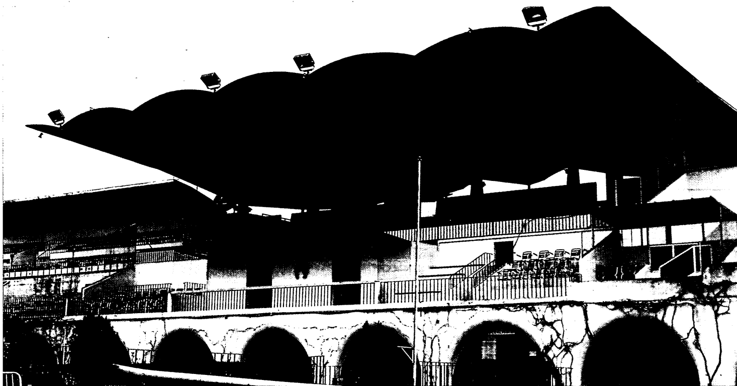
Figura 6.- Hipódromo de la Zarzuela (Madrid). (Detalle de la cubierta vista de frente). Eduardo Torroja.
