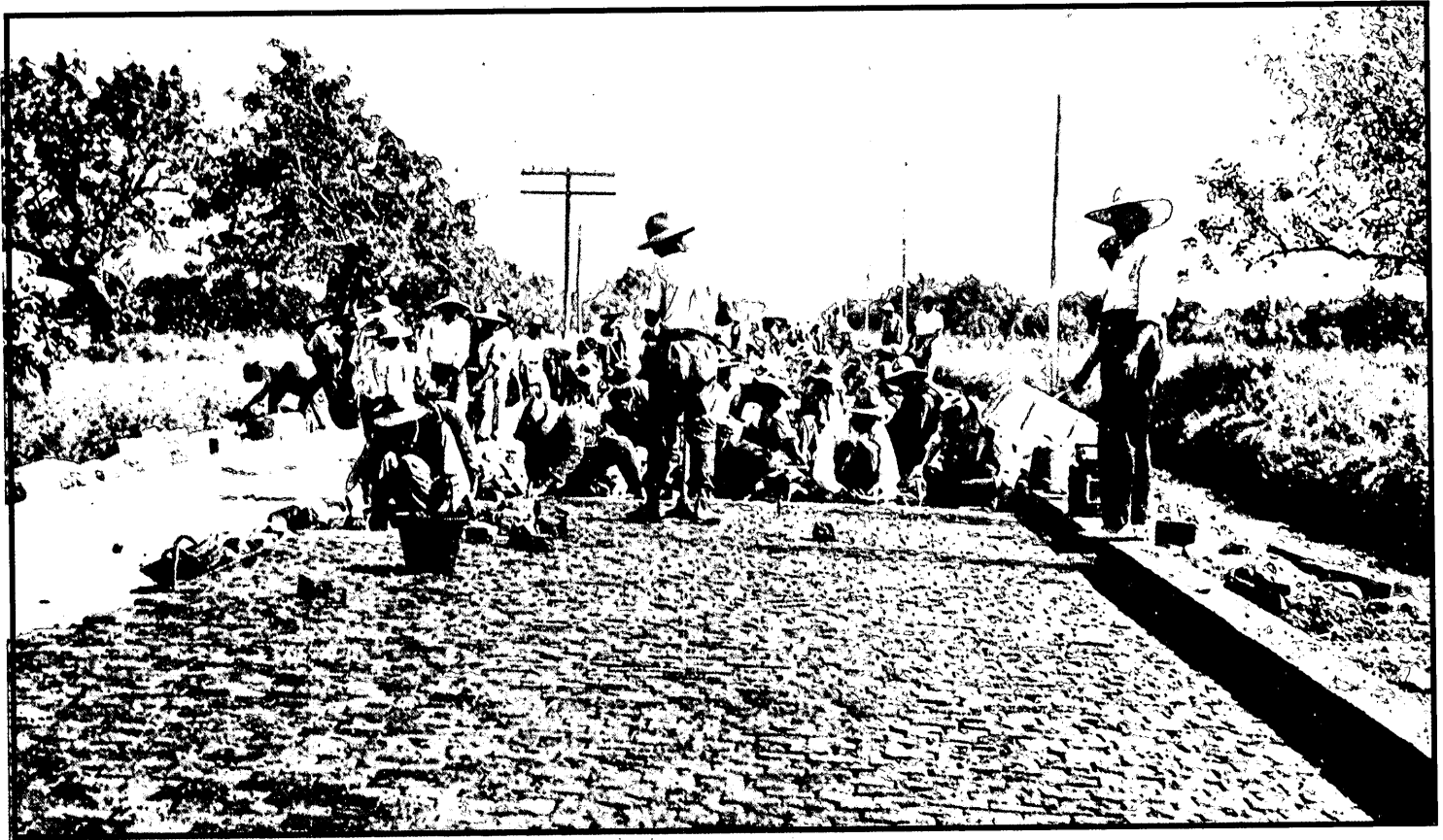
Figura 7 .- Los pavimentos del Circuito Nacional de Firms Especiales. Ejecución de un adoquinado en la carretera de Valencia a Castellón (Foto: CNFE, Memoria 1926-30).
