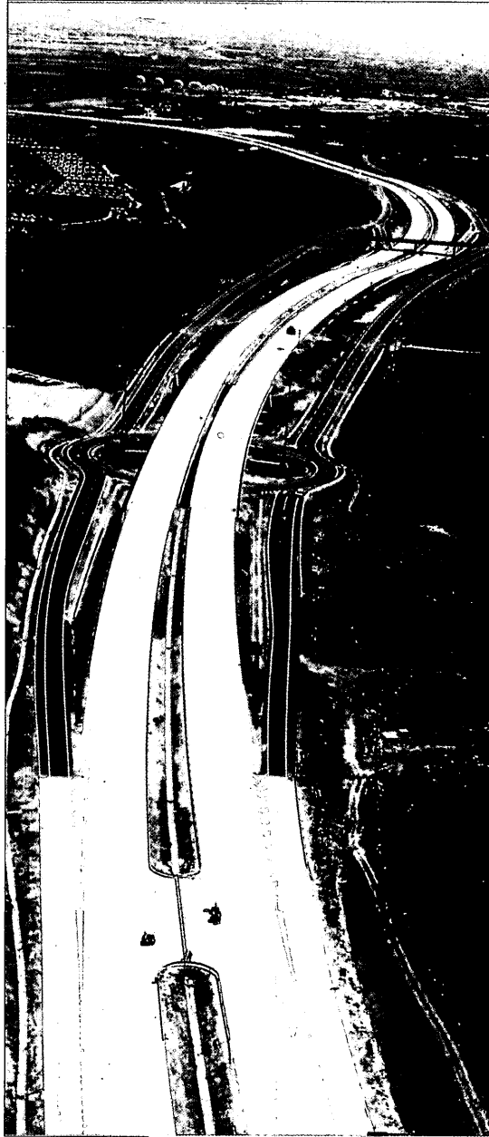
Autovía del Culebro M-50
