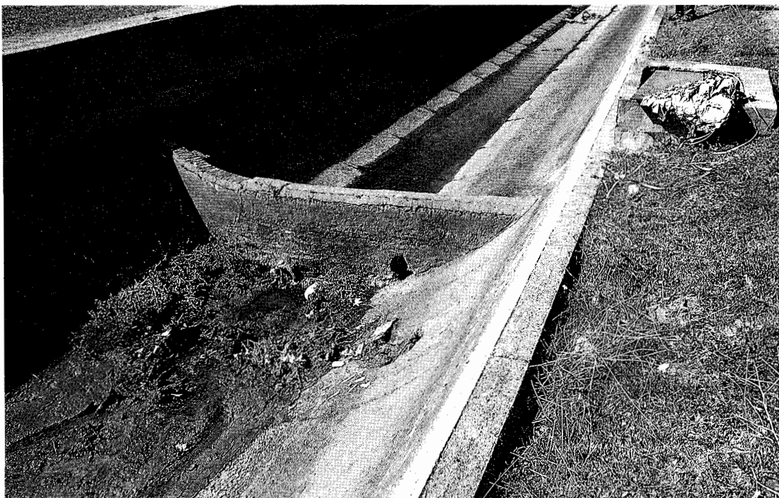
Figura 6. Vertedero que crea una retención para derivar agua por la toma de aguas arriba (Zújar).
