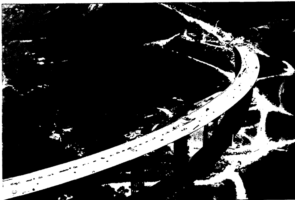
Vista general del puente en construcción.
