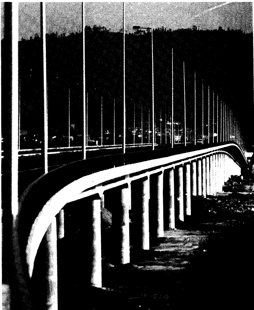
Detalle de pilas y coronación.
