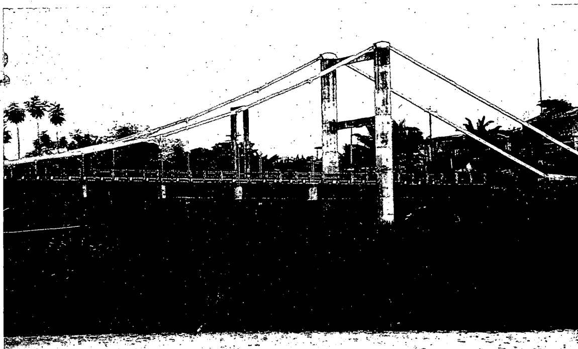
Vista general del puente.
