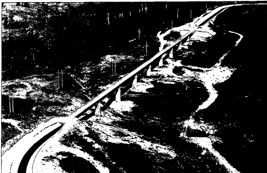
Canal Chongon-Playas-Acueducto Río Daule.
