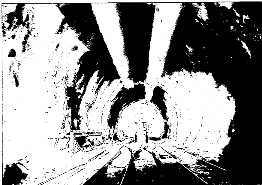
Excavación de túnel. Plataforma deslizante y vías para el desplazamiento del Jumbo.
