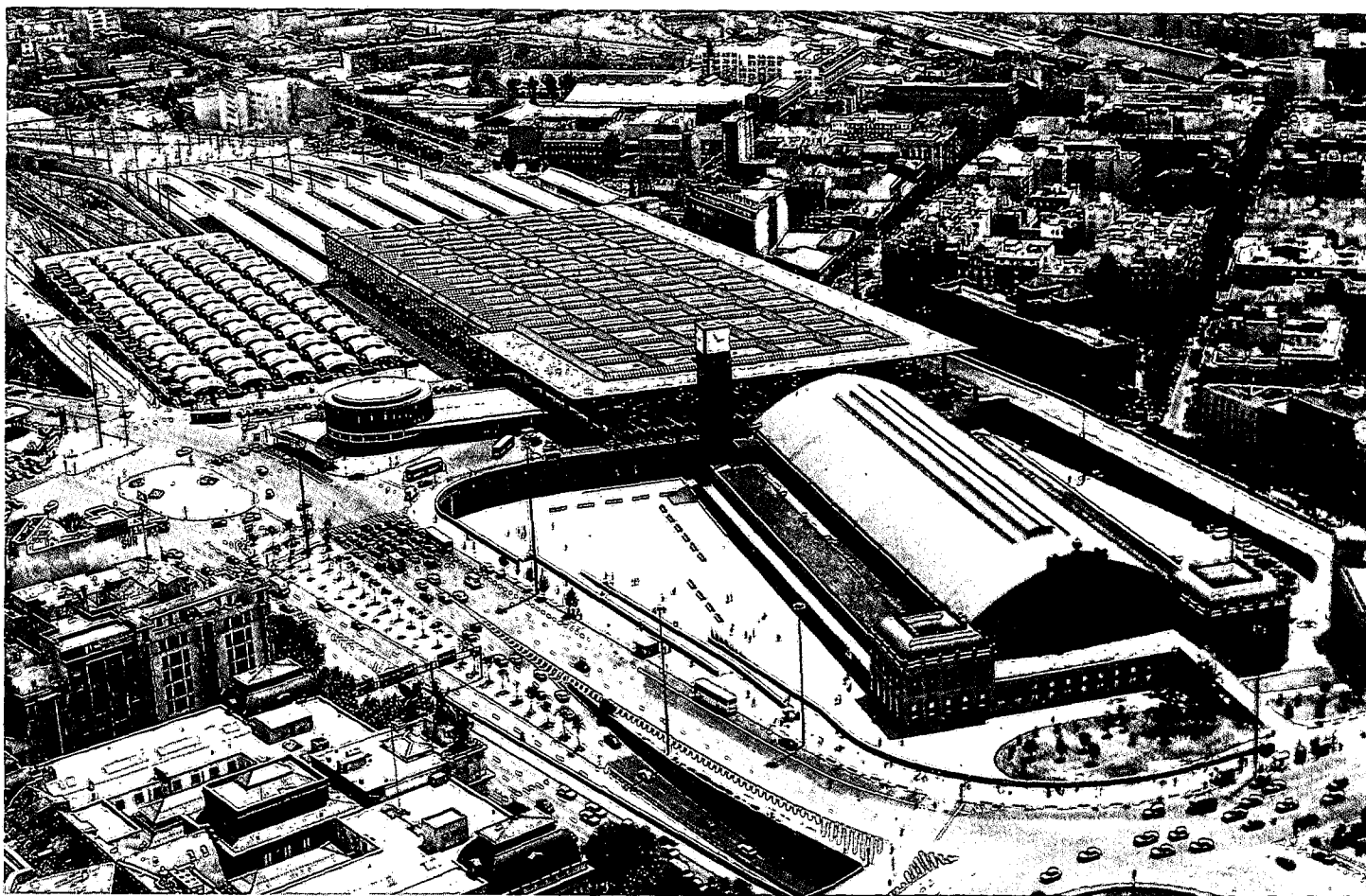
Panorámica aérea del conjunto de la estación.
