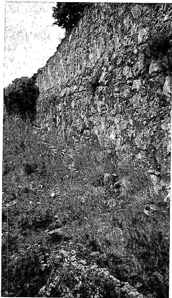
Fig. 2 Vista general del estribo izquierdo en la que se aprecian las tres zonas que lo componen.
