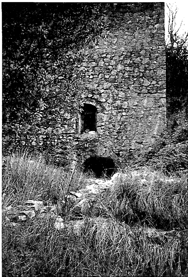
Fig. 9 Fachada del molino con salida del canal abovedada por debajo del mismo y ventana de la habitación donde estaría la muela.
