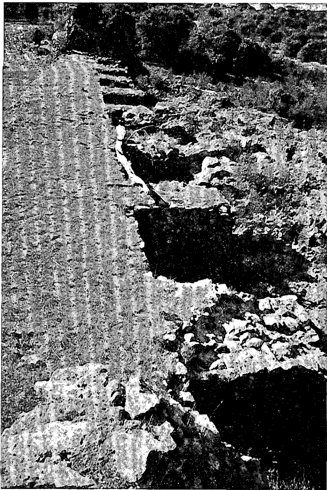
Fig. 5 Vista de la coronación de la zona central. Se observa su perfecta alineación y deducimos que corresponde al perfil primitivo de la primera reconstrucción ya que está a la misma cota en toda su longitud.
