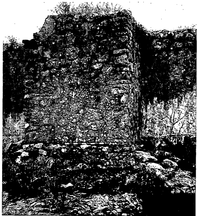
Fig. 6 Contrafuerte de la zona central donde observamos el asentamiento de éste aprovechando el afloramiento rocoso y que utiliza mampuestos trabados con mortero para igualar el nivel.
