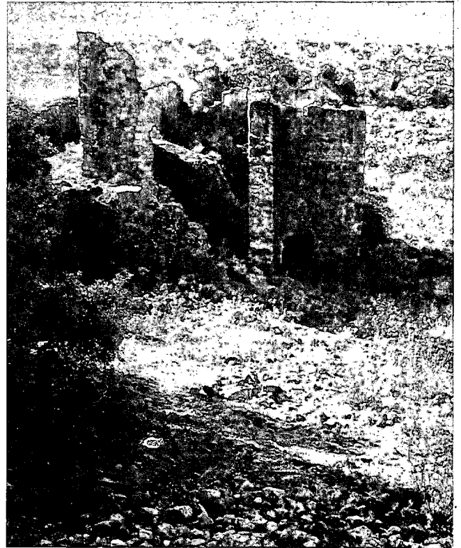
Fig. 8 Vista lateral del molino adosado a la presa. Se conservan prácticamente todos los cerramientos excepto la parte superior que está derruida.
