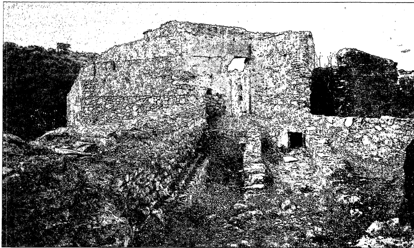
Fig. 10 Vista general del molino de agua abajo. Se aprecia la balsa donde terminaba el canal que servía de regulación y acometida al pozo del interior del molino.
