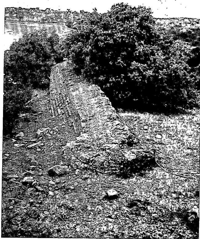
Fig. 3. Base para un motivo ornamental en el estribo derecho de la presa, que data de su última reconstrucción.
