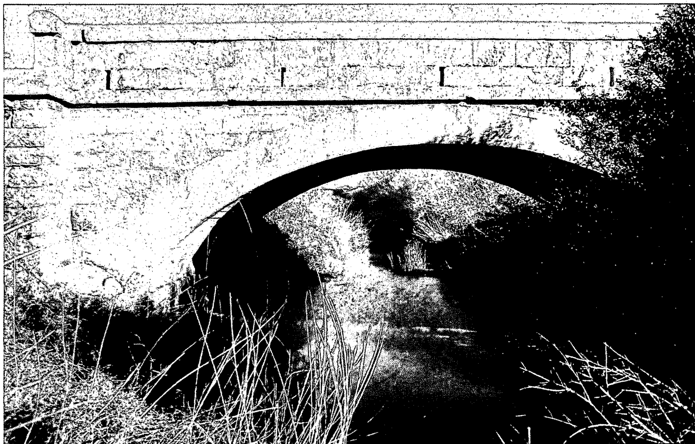
Foto 3.—Perspectiva del puente sobre la ría de Solía (Los Autores)
