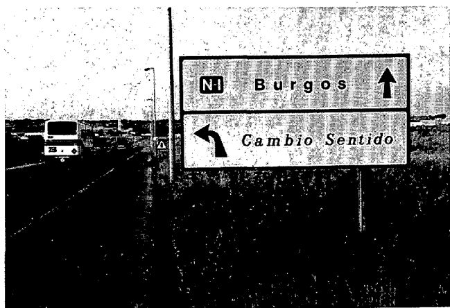
Fotografía 3. Cartel de vitro-resina que lleva muchos años en servicio. Los adyacentes de lamas de metal han sido robados varias veces. Este cartel sufrió un golpe, como el de la Fotografía 2, pero quedó intacto.
