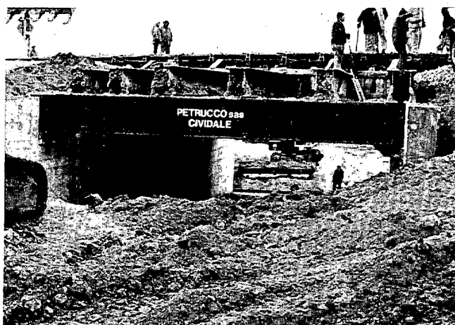
Foto 4.—Apoyo/PN sobre viga-cajón.
