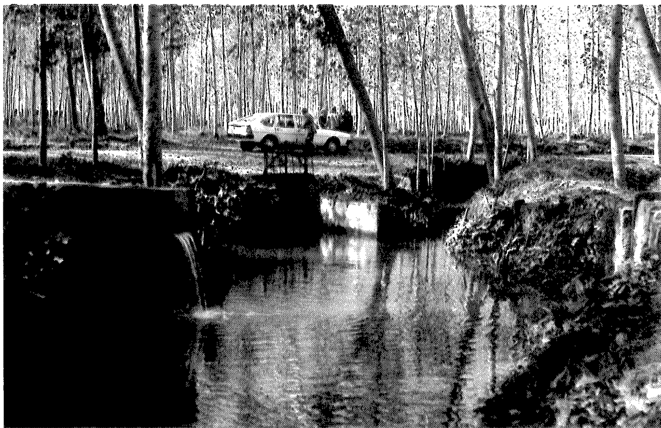
FOTO 6.—Boca de entrada del sifón de Jotayar. La rejilla nos impidió tomar la sección del sifón; no obstante, comprobamos que su longitud coincidía con la definida por Betancourt, el coche por tanto está situado en la antigua madre del Genil cuando don Agustín construyó el sifón. La acequia de la derecha debe de ser posterior pues puede funcionar como aliviadero del sifón, detalle éste que notaron su falta los ingenieros militares.
