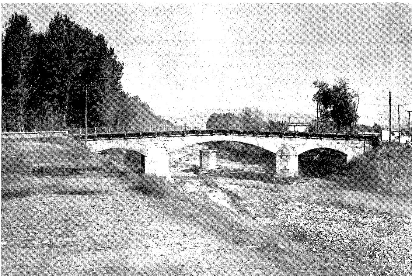
FOTO.1.—Puente llamado de los Vados, construido con posterioridad en las cercanías en donde Betancourt proyectó uno de madera para facilitar el paso a sus trabajadores. En la foto puede apreciarse los arrastres del río que levantaban y alteraban la madre del río según el ingeniero canario.
