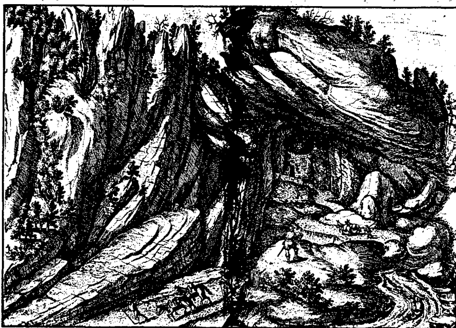
El túnel de San Adrián.
