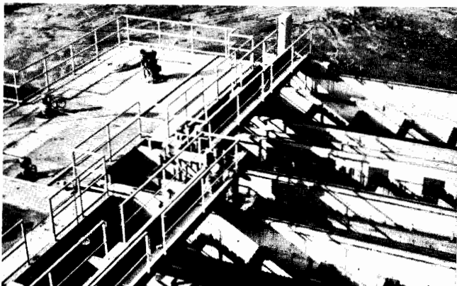
Estación depuradora de Agde. Decantador lamelar RPS.
