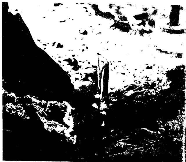
Figura 2.—Dren instalado en el terreno.
