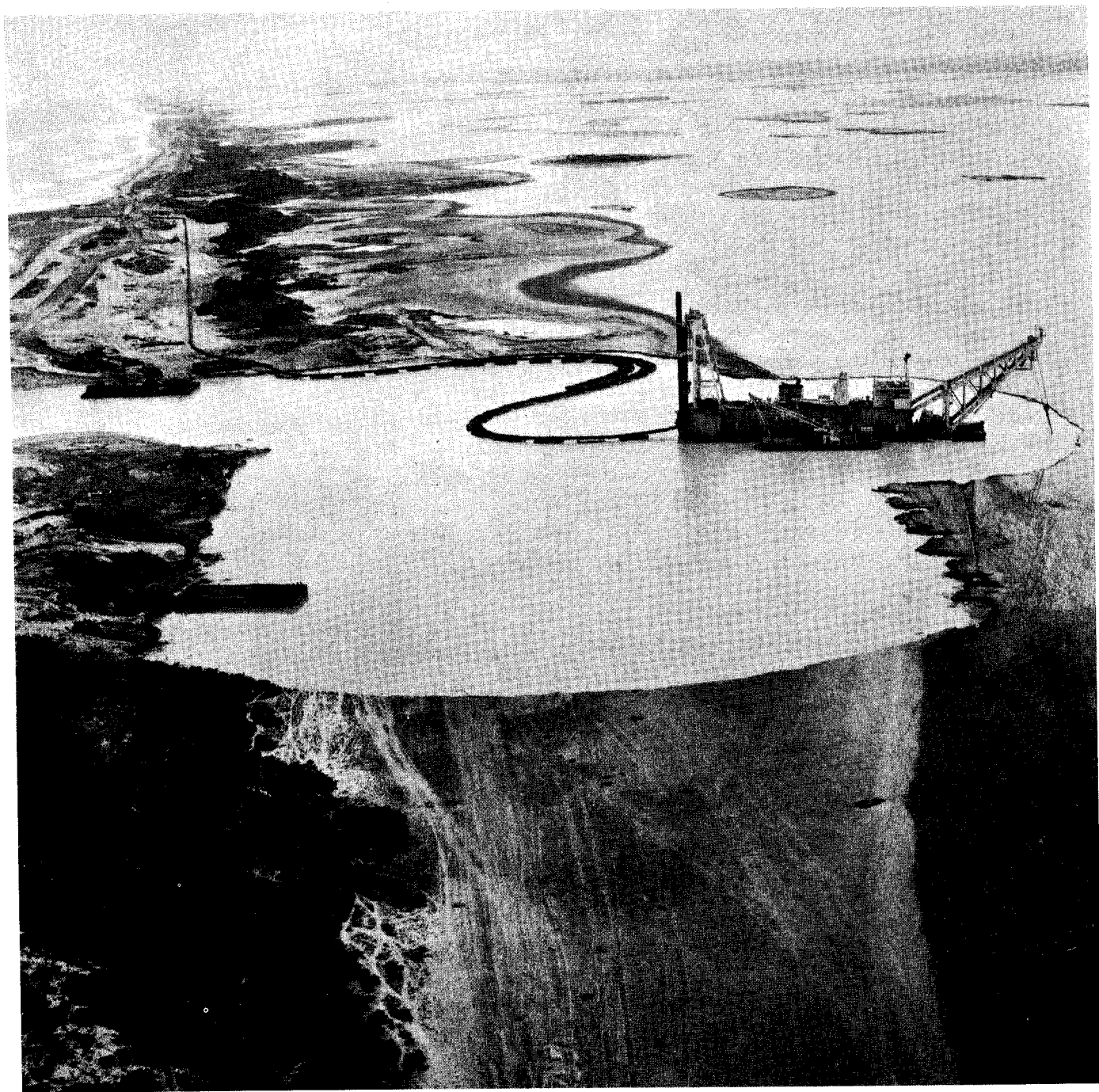
Dragado en la construcción de un puerto industrial en Altamira (Costa del Golfo, en México).
