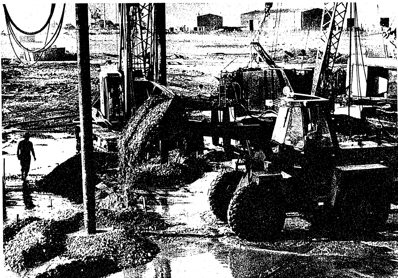
Fig. 3. Suministro del material de aportación a las perforaciones con una pala mecánica.
