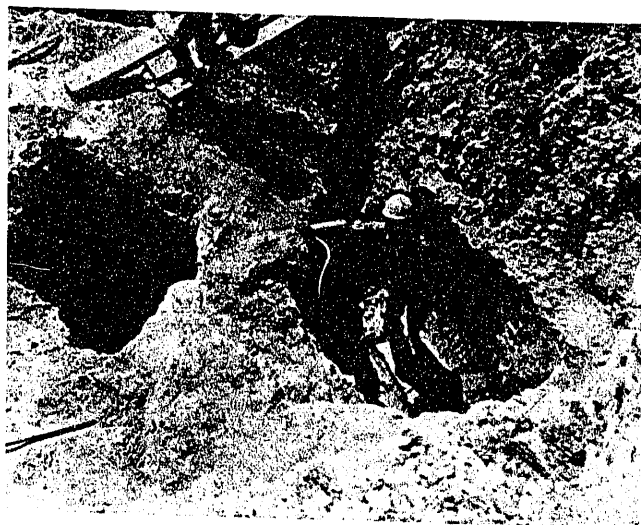
Pila nº 49. Detalle de parte de las labores romanos descubiertas en cimentación; Obsérvese que están inundadas previamente a su agotamiento.
