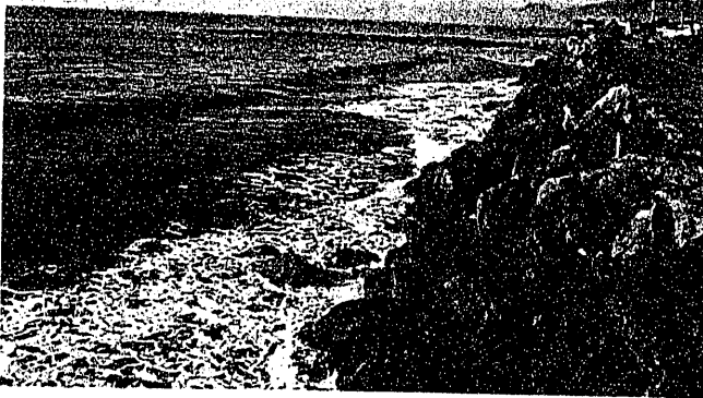
Fig. 7.—Escollera en la zona erosionada junto al puerto de Castellón por el Sur.
