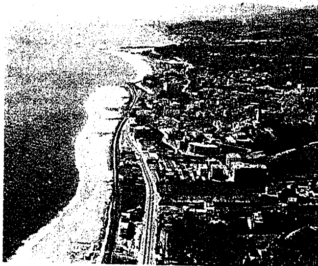
Fig. 15.—Acumulación originada por el espigón de La Catell. Al fondo, puerto de Arenys de Mar y su acumulación correspondiente.
