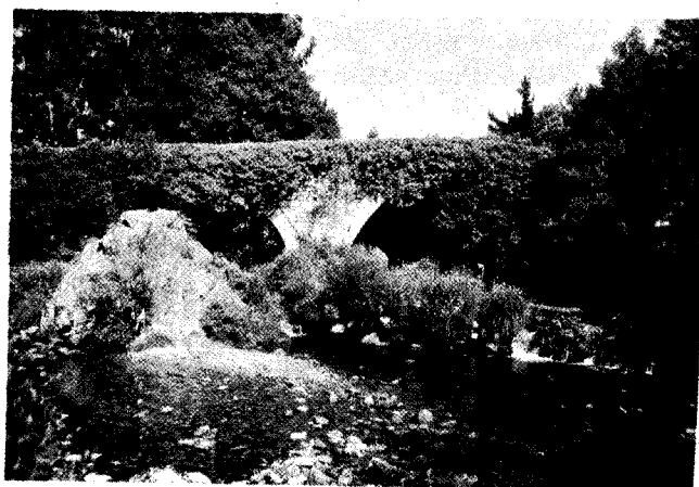
Puente Furelos. Detalle de tímpanos.
