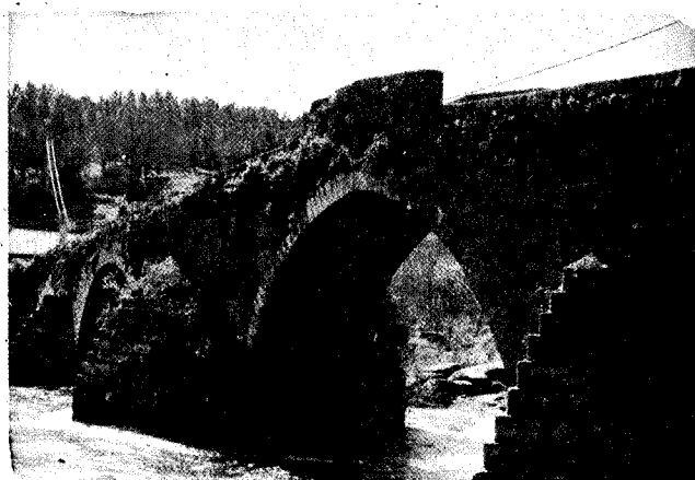
Puente Maceira. Vista de los arcos centrales.
