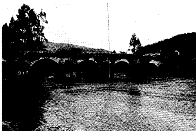
Puente Ledesma. Vista General desde aguas arriba.
