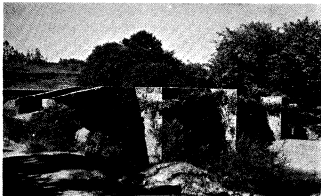
Puente de Brandomil. Vista desde aguas abajo.
