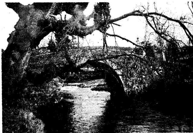
Puente Romano de Puentes de García Rodríguez. Vista general.
