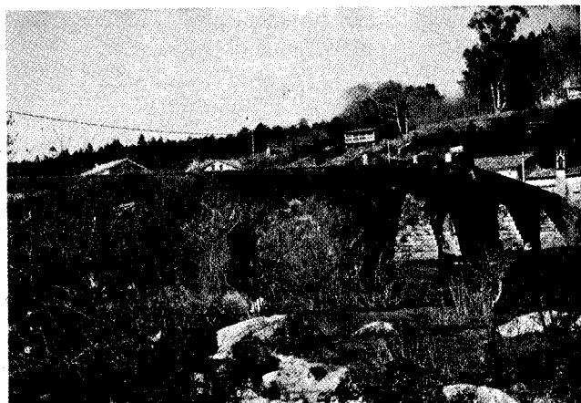
Puente Maceira. Vista General.
