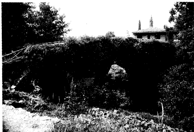
Puente Furelos. Vista desde aguas abajo.
