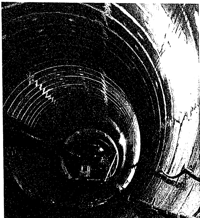
Fig. 7.—Vista del túnel terminado.
