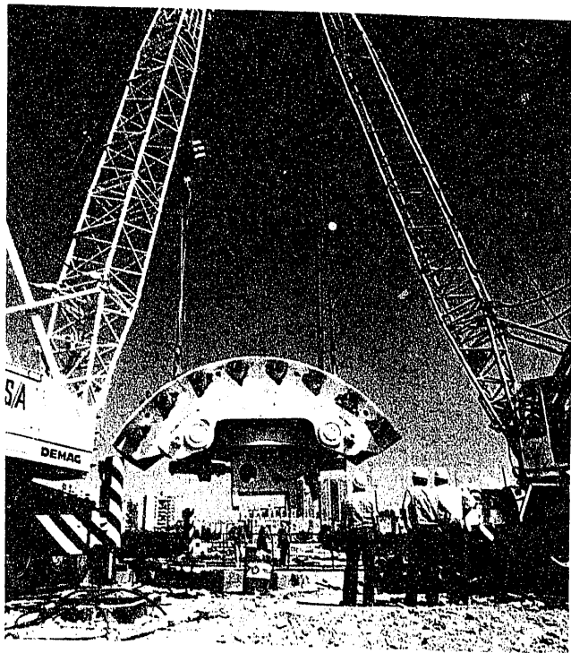
Fig. 4.—Parte superior del sector central izado sobre el pozo de entrada.
