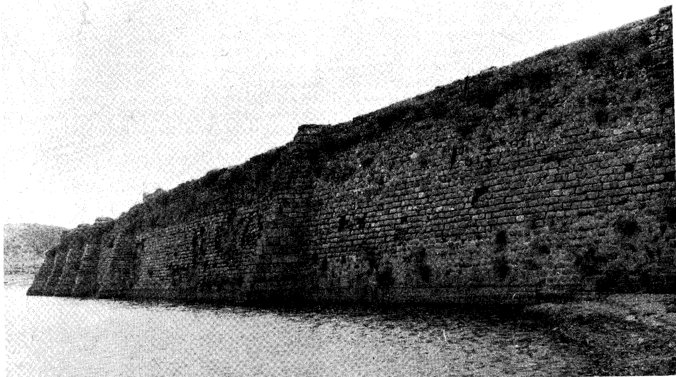
PRESA DE PROSERPINA. Mitad correspondiente al estribo derecho antes de la restauración de 1940.
