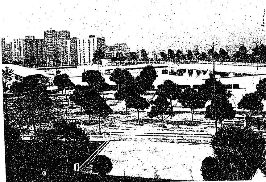
Piscina del Parque deportivo de La Elipa
