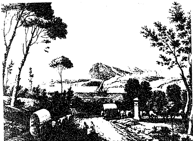
Una carretera nueva del siglo XVIII. Obsérvense las losas en el arcén y el poste cuentaleguas.
