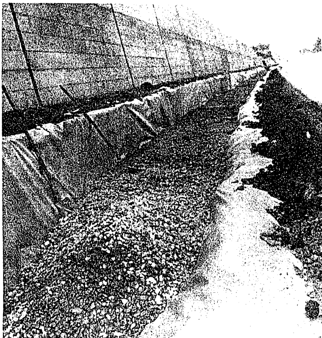
Aplicación de los textiles en drenaje: zanjas drenantes tipo "francés". (fotos cortesía de Expandal - TYPAR)
