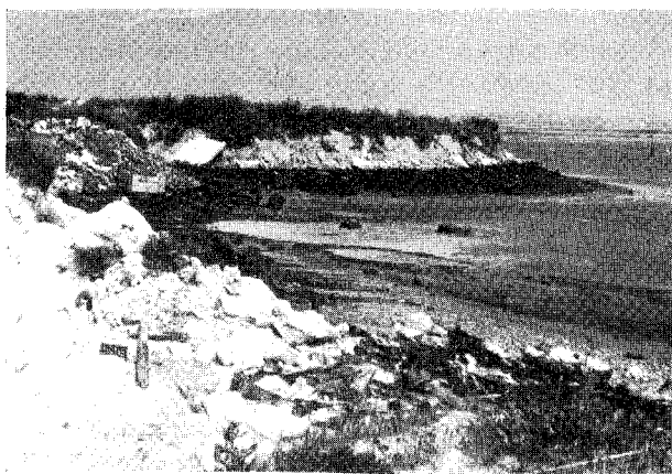
Fig. 9.—Detalle de los materiales utilizados para relleno de la zona del nuevo puerto de Raos. Se puede apreciar la alta contaminación de las aguas en esta zona por la impregnación de grasa que se observa por debajo de la línea de pleamar (relleno comenzado en 1957 y que actualmente prosigue).
