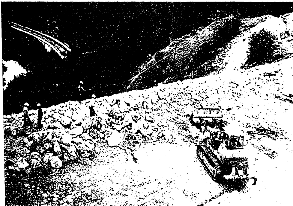
Fig. 4.—Método de ejecución del relleno en el borde exterior de cada tongada.
