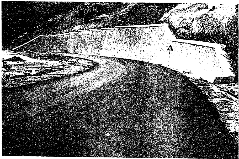
Muro proyectado por don Luis Chocano en la carretera de Andalucía (Despeñaperros).
