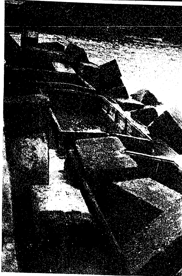
Aspecto actual de la gabarra exterior de Candás protegida con bloques.
