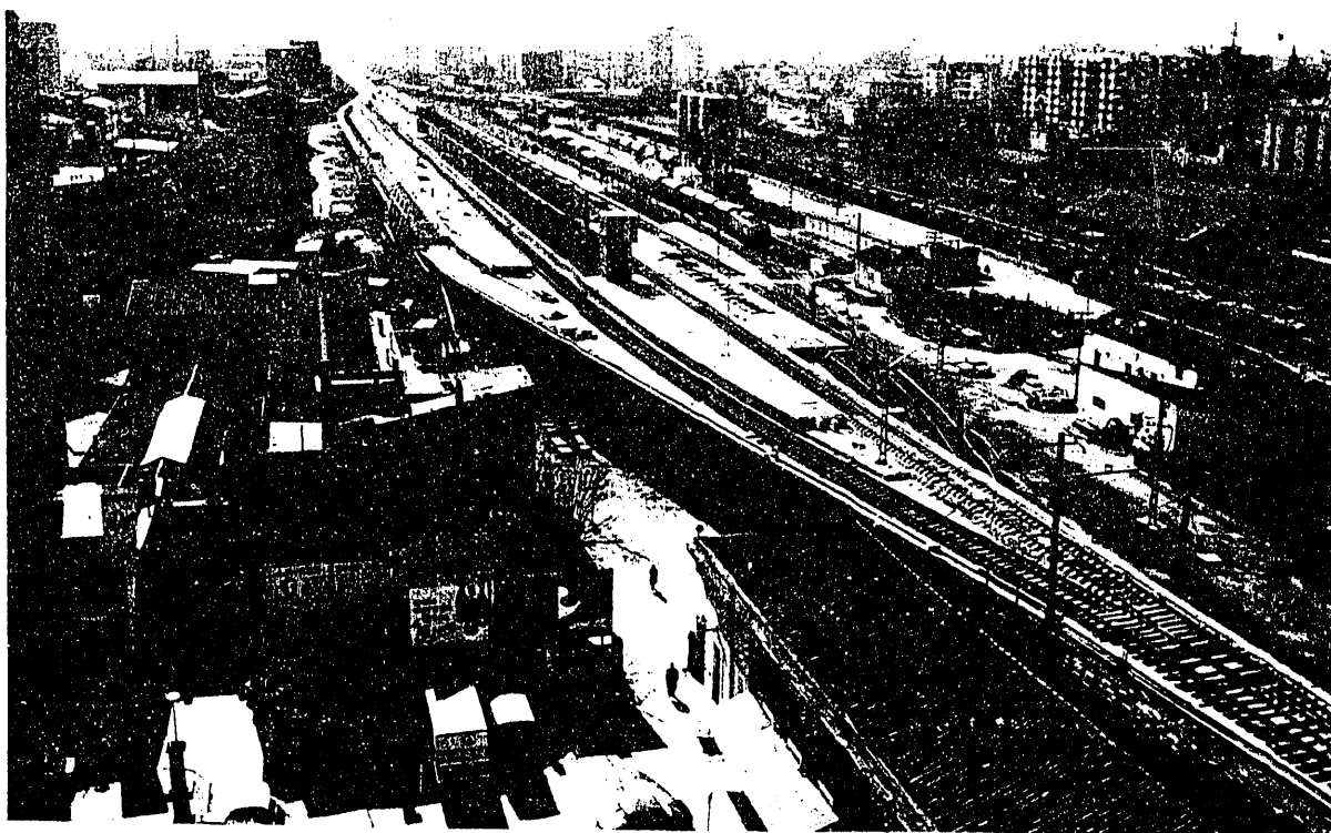
Gerona: vista de la nueva estación de viajeros, durante su construcción.
