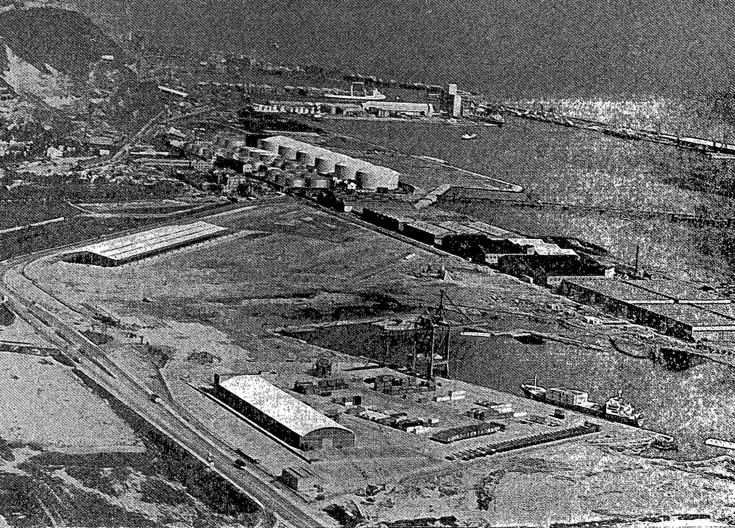
Vista general del terminal para contenedores y transportes combinados, en construcción (Barcelona).
