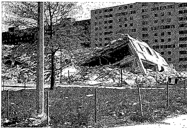
Foto 2. — Demolición de los bloques municipales en Saint Louis (USA) como consecuencia del rechazo social.
