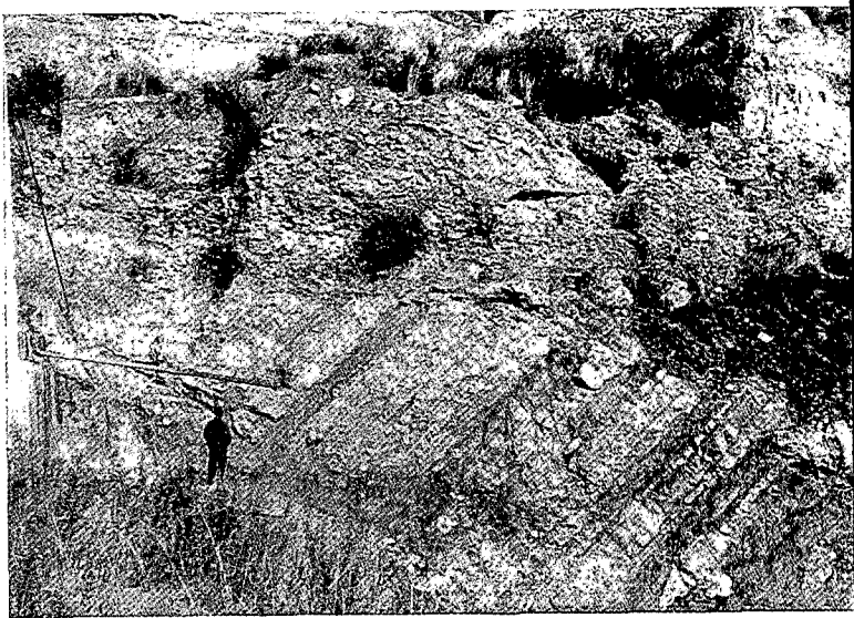
Foto 6. — Frente de excavación en el cauce. Formaciones continentales (conglomerados, calizas, arcillas, etc.) coronadas por formaciones cuaternarias.
