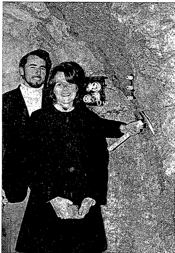
Foto 12. — Detalle de otra de las fallas relacionada con la presa (galería cota 104 de la ladera izquierda). La zona milonitizada, perfectamente consolidada e impermeable, está señalada por el martillo. ¡Tampoco esta falla muerde!
