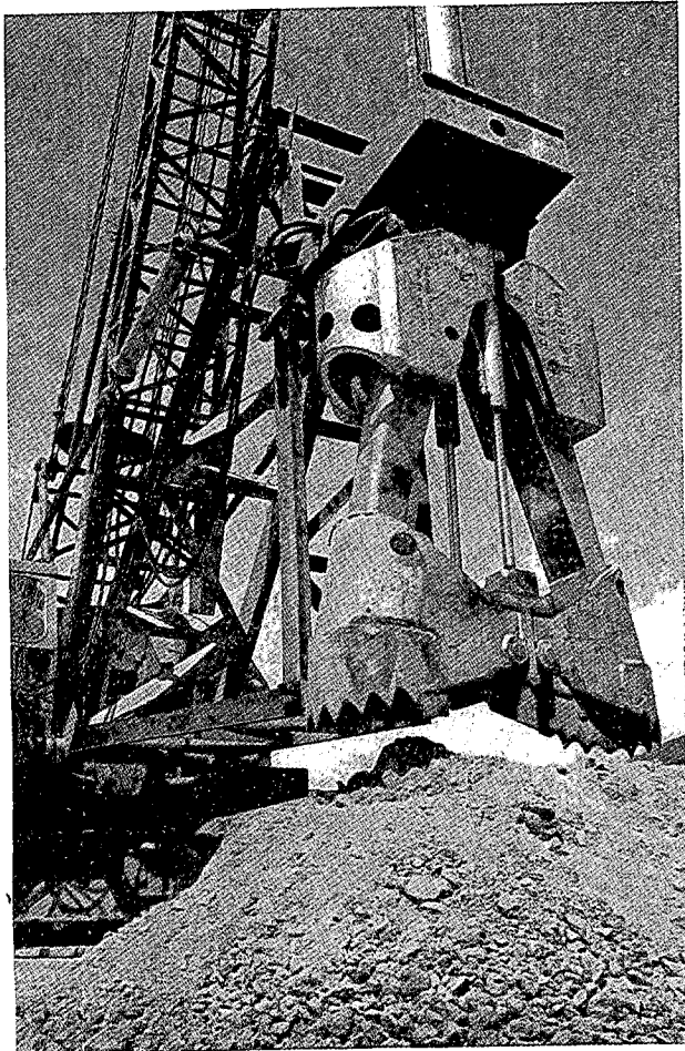
Foto 4.—La maquinaria parada incide en el coste de la unidad. Si d_c son los días de parada, el coste unitario es \frac{K_1 \cdot d_c}{n} . Normalmente el cliente paga \frac{\alpha \cdot K_1 \cdot d_c}{n} ( \alpha \leq 1 ) (ley de mercado) y el resto el contratista de cimentaciones. Por ello, las paradas en obras de cimentaciones no interesan a ninguno de los dos.
