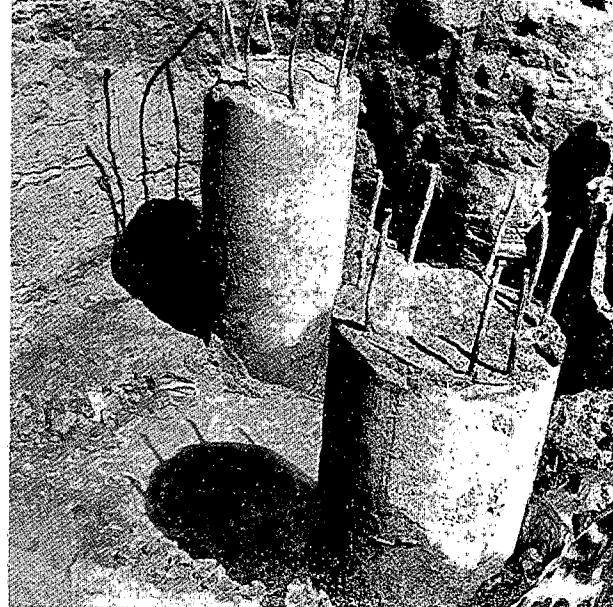
Foto 2.— La partida más clara que incide en el costo directo K_2 (ptas./ud.): los materiales incorporados en la unidad, que en el caso de la foto son hormigón y acero. A éstos se añadirán materiales gastados, consumos, etc.
