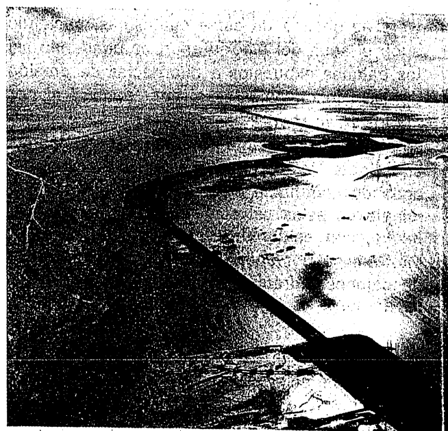
Foto 4.—Un momento histórico en las efemérides de la ingeniería hidráulica holandesa: el cierre del Lauwerszee es una realidad. En primer término el tramo del dique que enlaza con la costa de Frisia. En el centro, la isla de trabajo "Lauwersoog", y detrás de la misma, el dique hacia el continente de la provincia de Groninga. A la derecha del dique, la región del Lauwerszee cerrada, y a la izquierda, el Waddenzee. (Foto Bart Hofmeester.)
