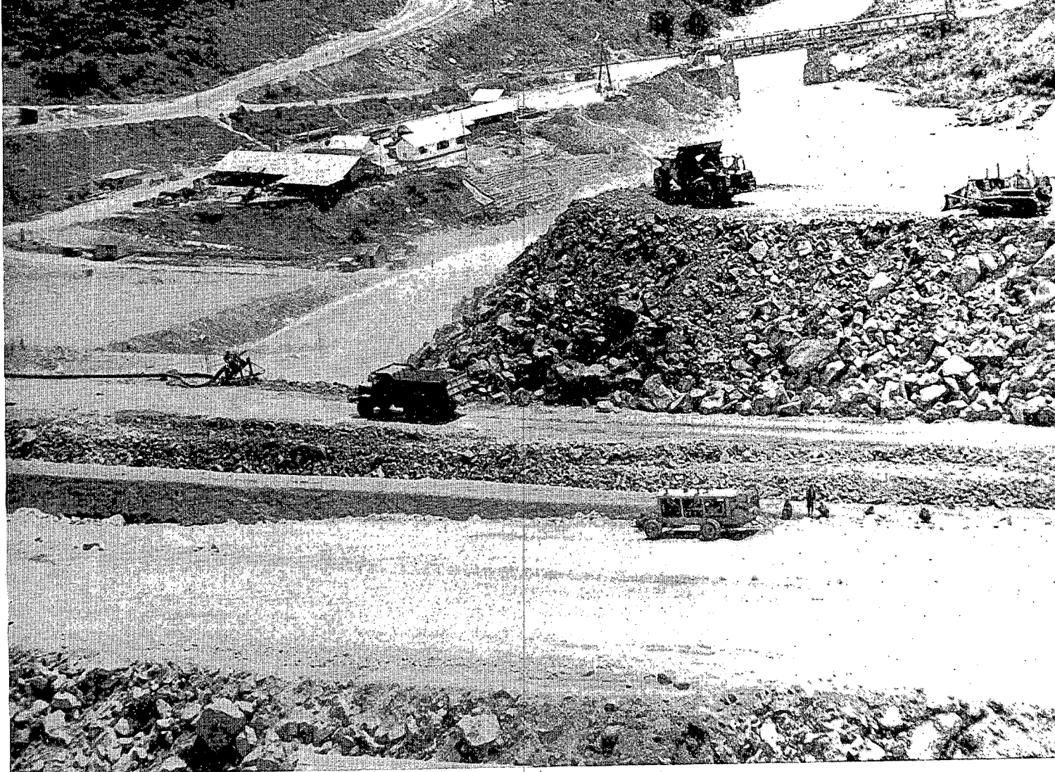
Fig. 5.—Puesta en obra de la escollera y riego posterior.
