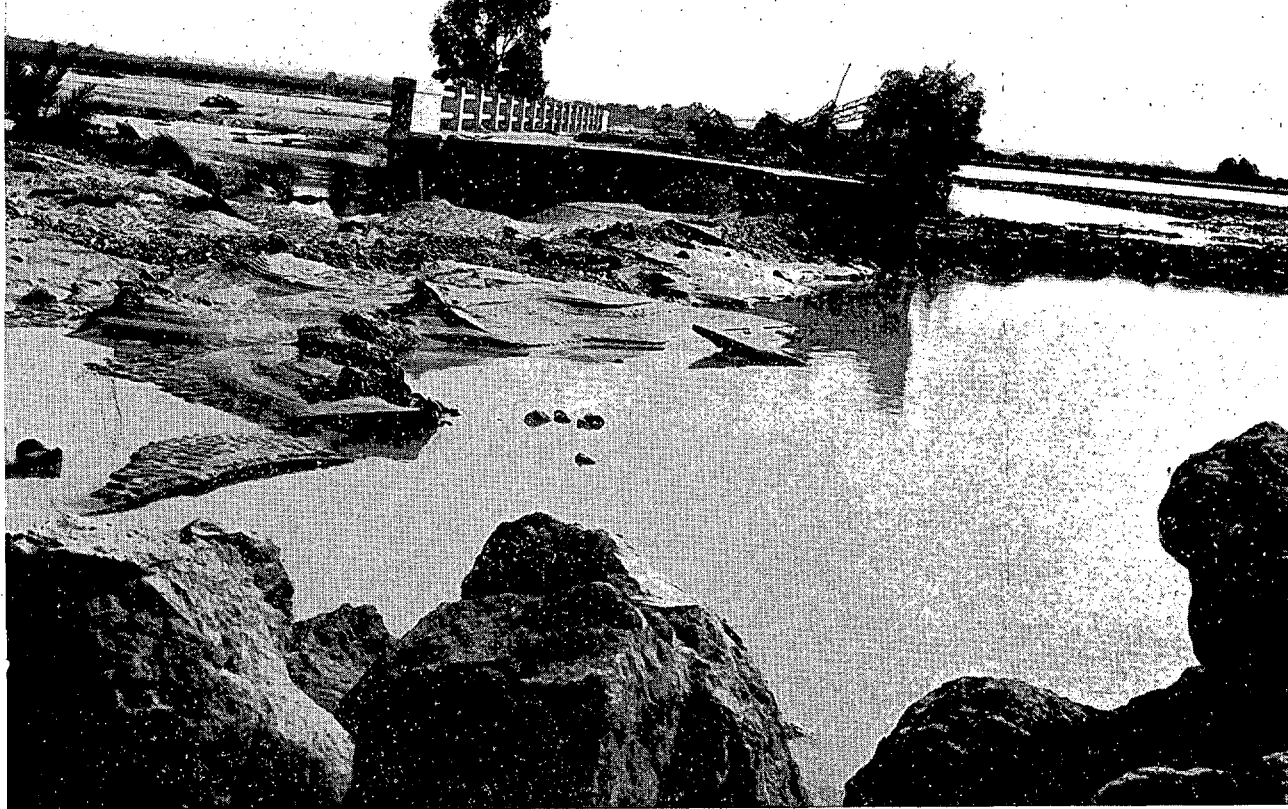
Estado de uno de los puentes que figuran en la fotografía anterior tras la tercera crecida, de 20 de octubre.
