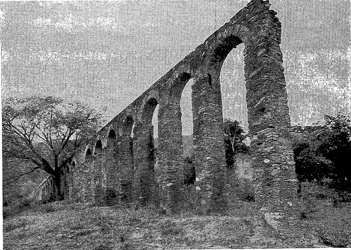
Acueducto de la Victoria.
