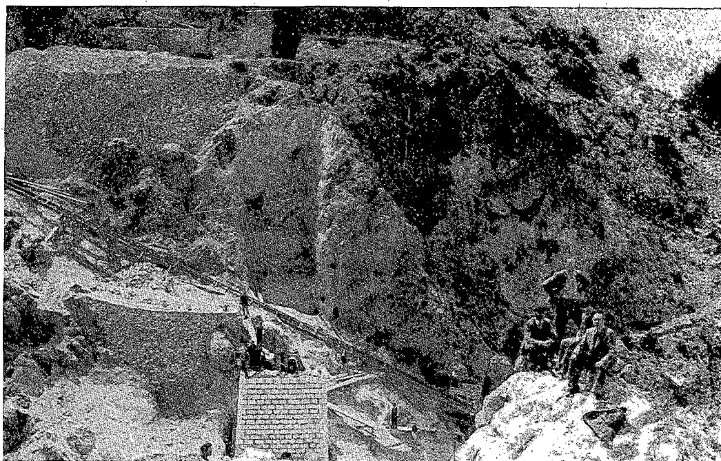
Fig. 5. — Trozo primero de los canales del Taibilla.
