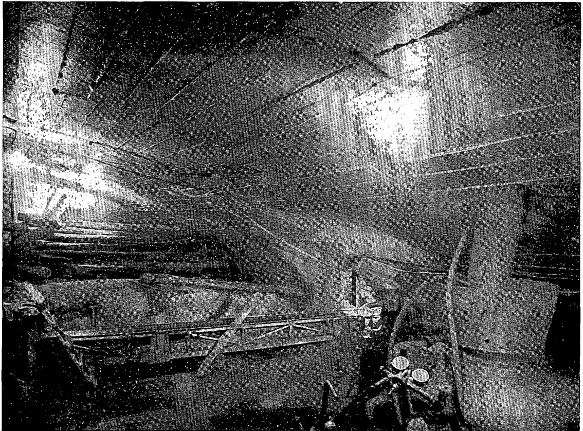
Bomba de hormigonado y cinta de extracción.
