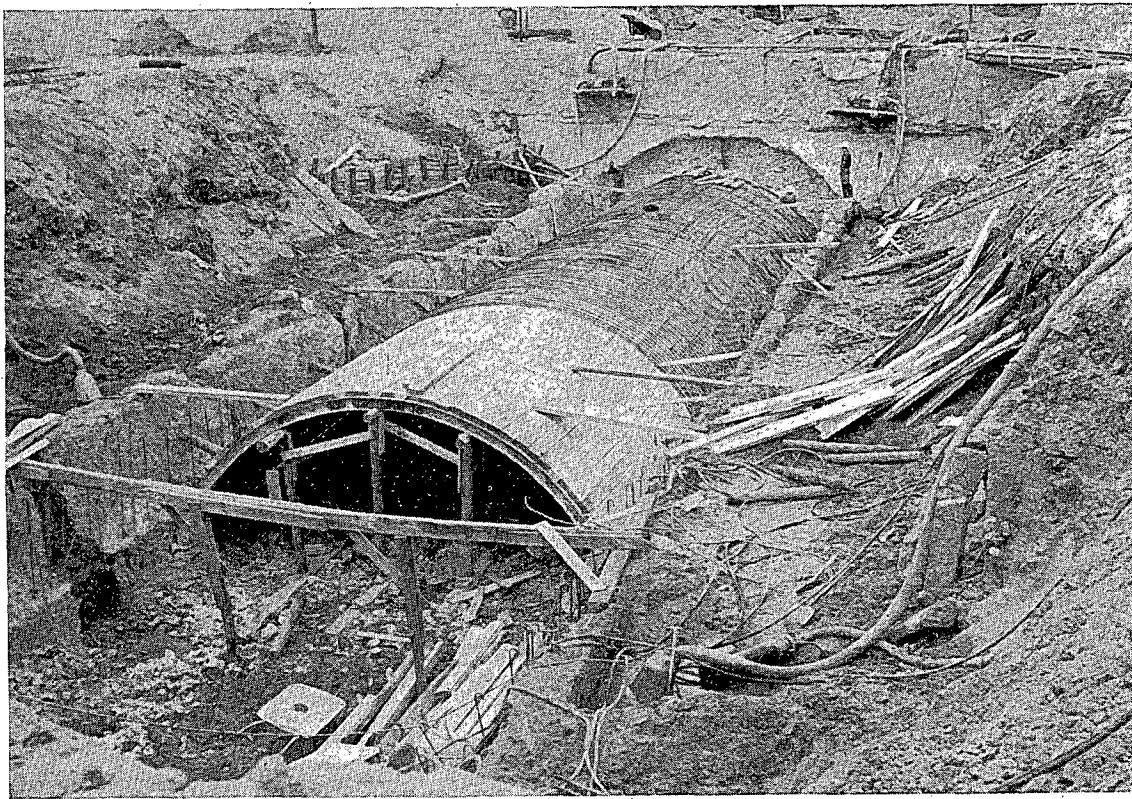
Encofrado de bóveda en el cruce con el río Manzanares.
