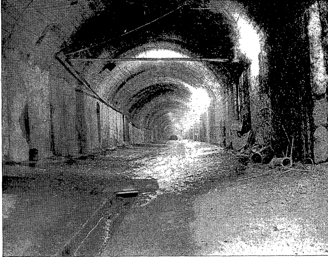
Túnel bajo el río, terminado. Se ven los hastiales excavados con el sistema Else-Lorenz en el primer plano.
