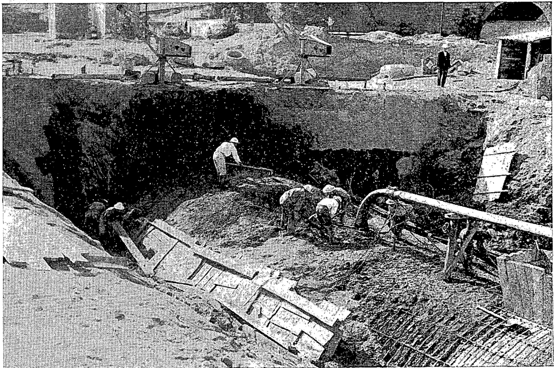
Hormigonado de bóveda en el Manzanares.
