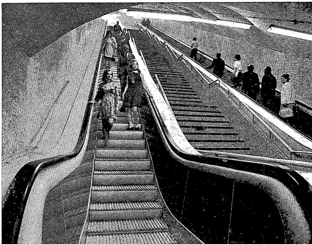
Escalera mecánica en la estación Latina.
