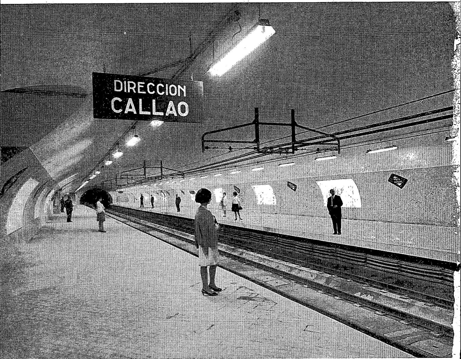
Estación de 90 m. de longitud con capacidad para trenes de seis coches.
